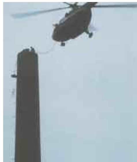
ABBRUCHARBEITEN AN EINEM SCHORNSTEIN
