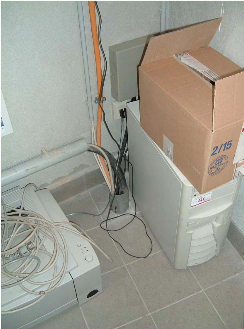
Potentielle Brandgefahren lauern auch in Elektrounterverteilungen sowie Serverräumen. Aus Zeit- und Platzgründen werden diese Räume zur Endlagerung von Kabel, Verpackungsmaterialien und nicht mehr benötigter Hardware genutzt.
