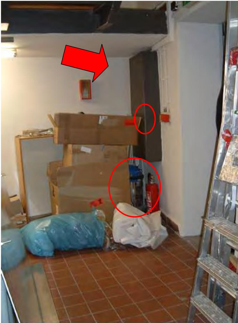
Reinigungskräfte nutzen den Zugang zum Treppenhaus regelmäßig zur Lagerung von brennbaren Abfällen.
