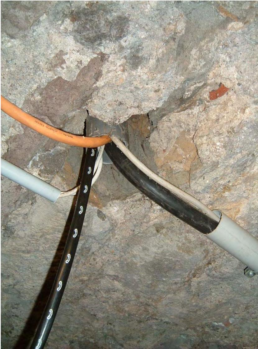
Bei nachträglichen Installationen wird regelmäßig das korrekte Verschließen der Decken- und Wanddurchbrüche „vergessen“.
